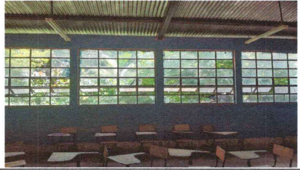
foto 2: aplicación y cambio de pintura en pared exterior e interior.
