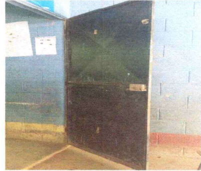
foto 4: sustitución de chapas para puertas de metal.
