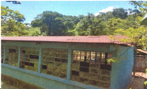
foto 1: sustitución de láminas, por láminas troquelada y sustitución de vidrios .
