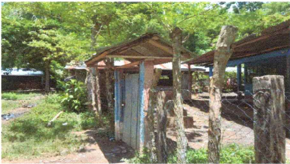
foto 3: Reparación de columnas de concreto para malla, sustitución de malla con soporte de tubos de metal y sustitución de portón.
